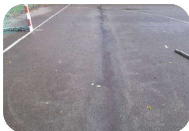
reparatie doelgebied overzijde
