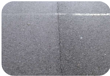
scheurvorming
