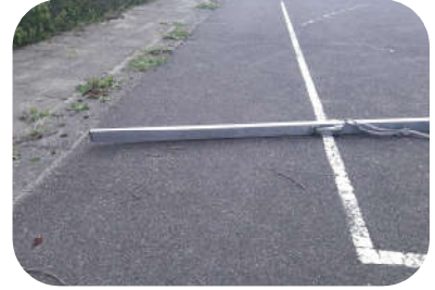
verzakking uitloop
