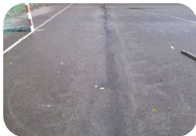
reparatie doelgebied overzijde
