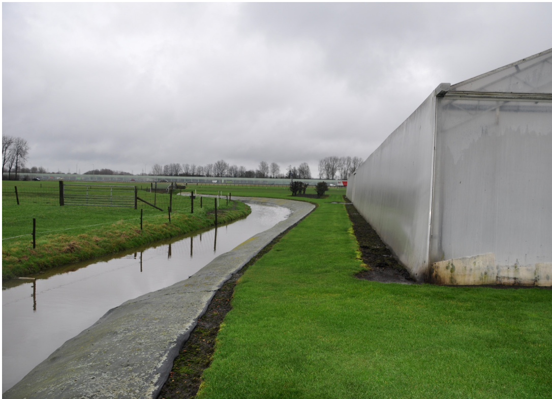
Watergang ten noorden van het kassencomplex.
