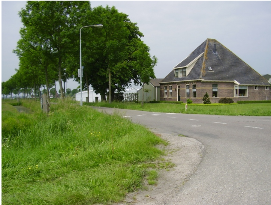
Figuur 5. Stolp gezien in oostelijke richting
