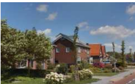
Dakopbouw met nokverschuiving naar achter
