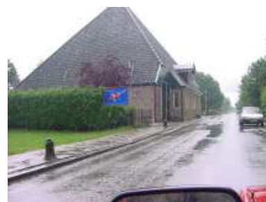
De voorgevel heeft een rijker karakter dan de zij- en achtergevel
