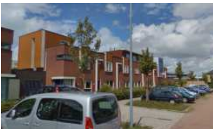
Dakopbouw op plat dak
