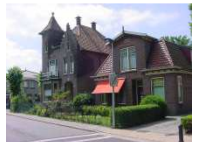
Renovaties, aan- of verbouwing in stijl aanpassen aan het oude gebouw
