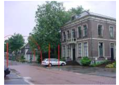
Renovaties, aan- of verbouwing in stijl aanpassen aan oorspronkelijke gebouw
