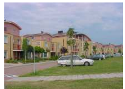
Vormgeving en materialisatie van gevels en dak afstemmen op de belendende panden of de karakteristiek van het pand
