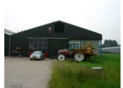
Een horizontale geleding in de kopgevel
