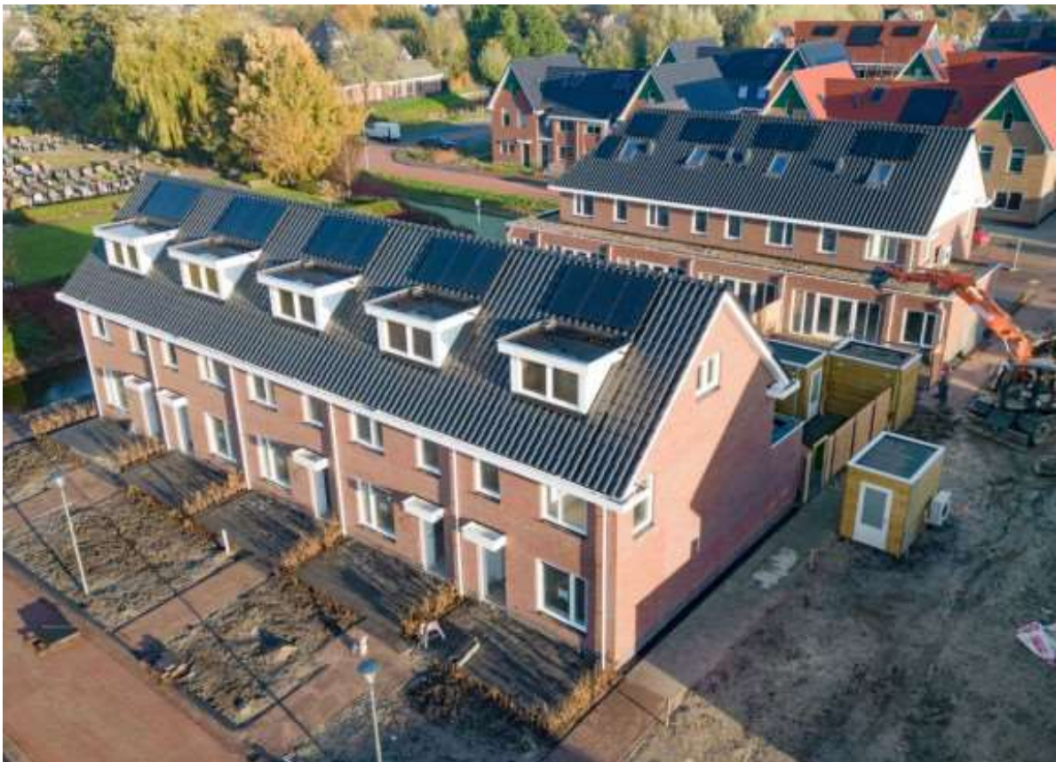
Dakkapel voorzien als voorbeeld van een Trendsetter
