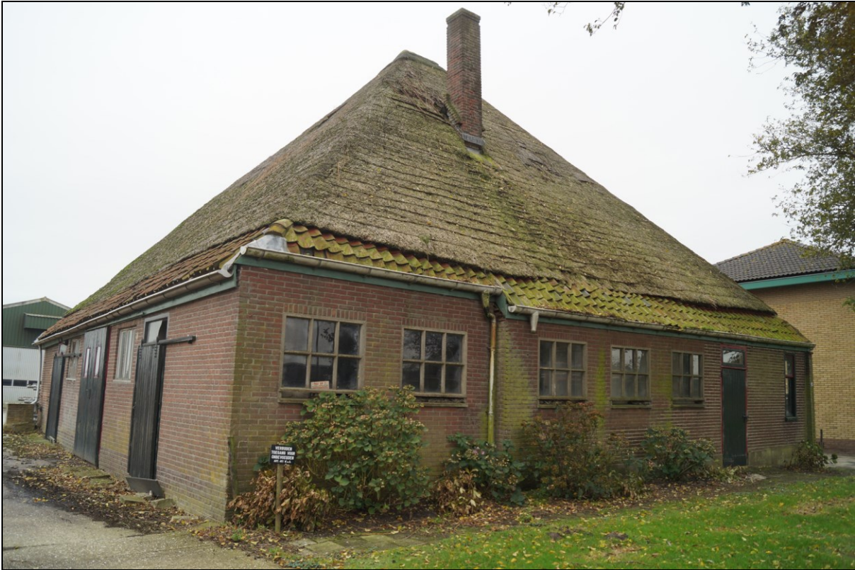
Afb. 2 De te slopen stolpboerderij, gezien vanaf de Noorddijkerweg, situatie oktober 2014.
