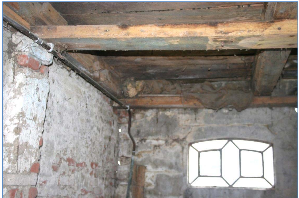
De ruimtes tussen dak en muur van de onderzochte stolp zijn dichtgestopt met lappen textiel.
