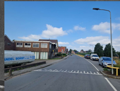
Brede "asfalt" rijbaan
