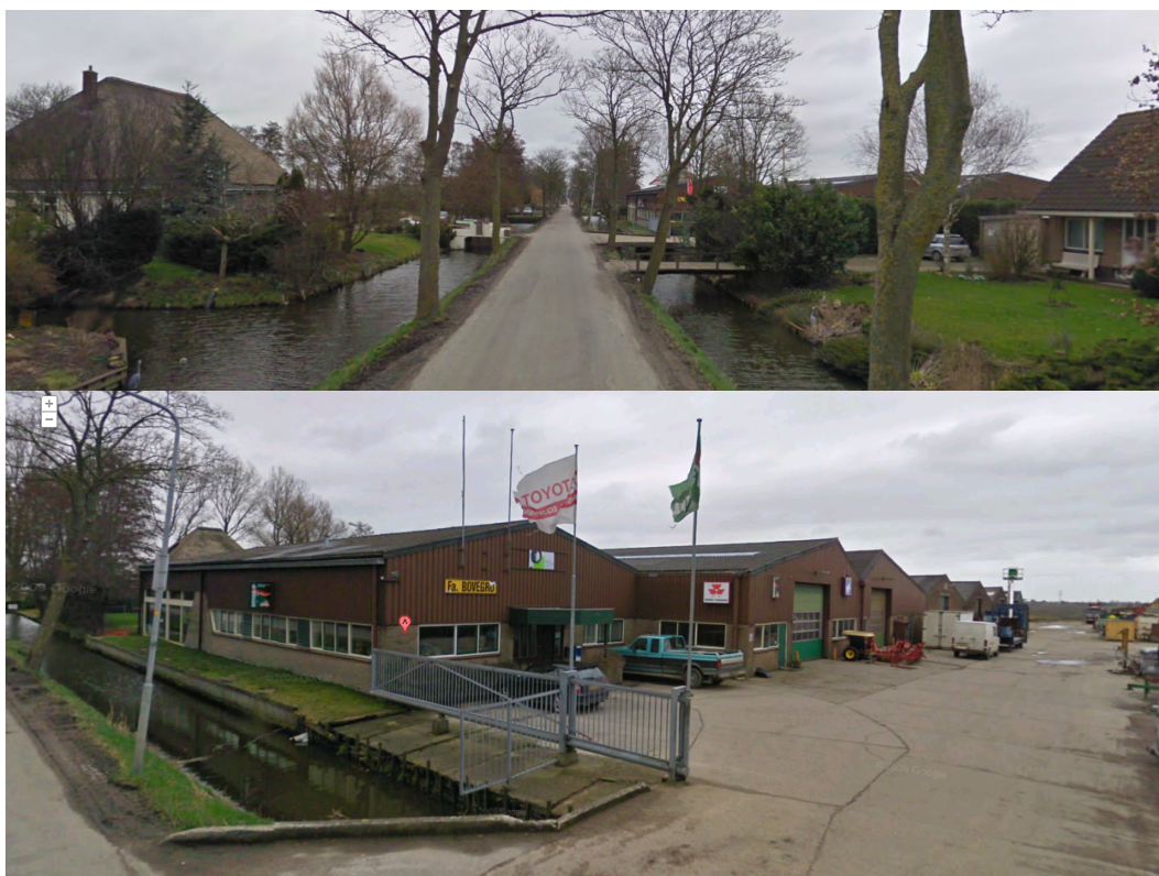
Figuur 4 Bebouwingslint en aanzicht bebouwing vanaf de Wogmeer
