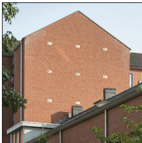
Afb 11 + 12: Gierzwaluwkasten ingemetseld (worden ook gebruikt door Huismussen)
