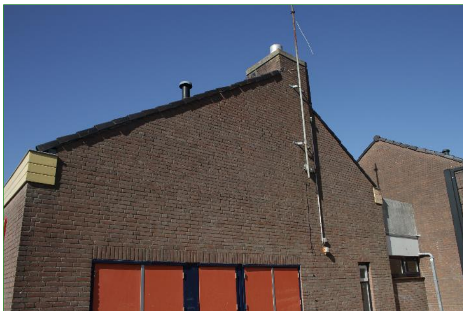
Aanzicht van een kapse kant van de bebouwing met een met dakpannen belegd dak.
