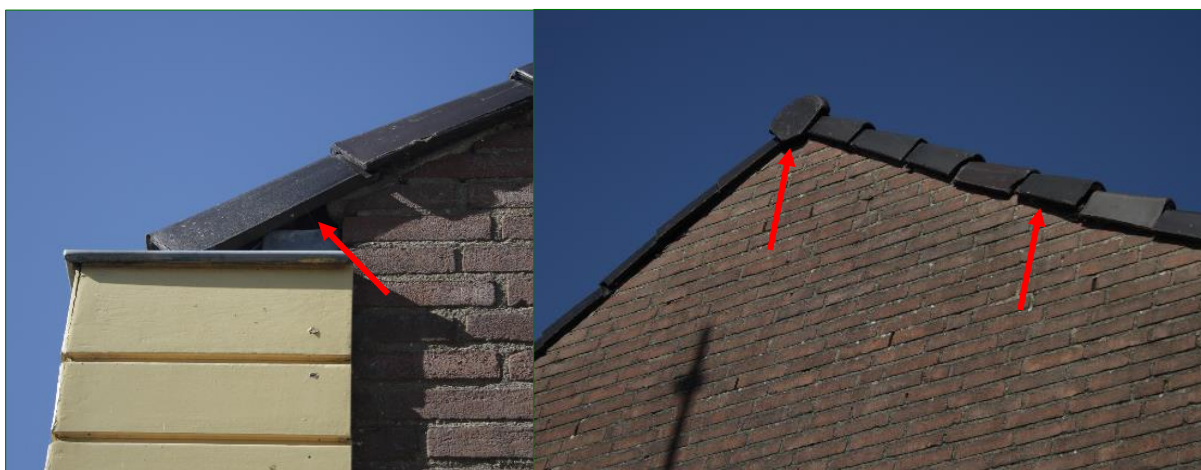
Ruimtes onder dakpannen (rode pijlen) kunnen toegang geven tot voor Huismus en Gierzwaluw geschikte nestplaatsen.
