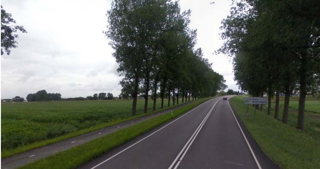
Figuur 3: Gebiedsontsluiting buiten de bebouwde kom (N243).
