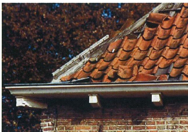
Voor het vervangen van slechte dakpannen door pannen van dezelfde soort en kleur is geen vergunning nodig.
