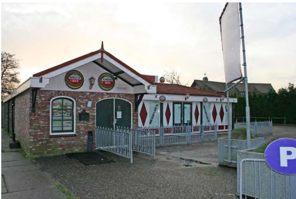
Figuur 2. Bestaande horeca-voorziening, te slopen bebouwing
