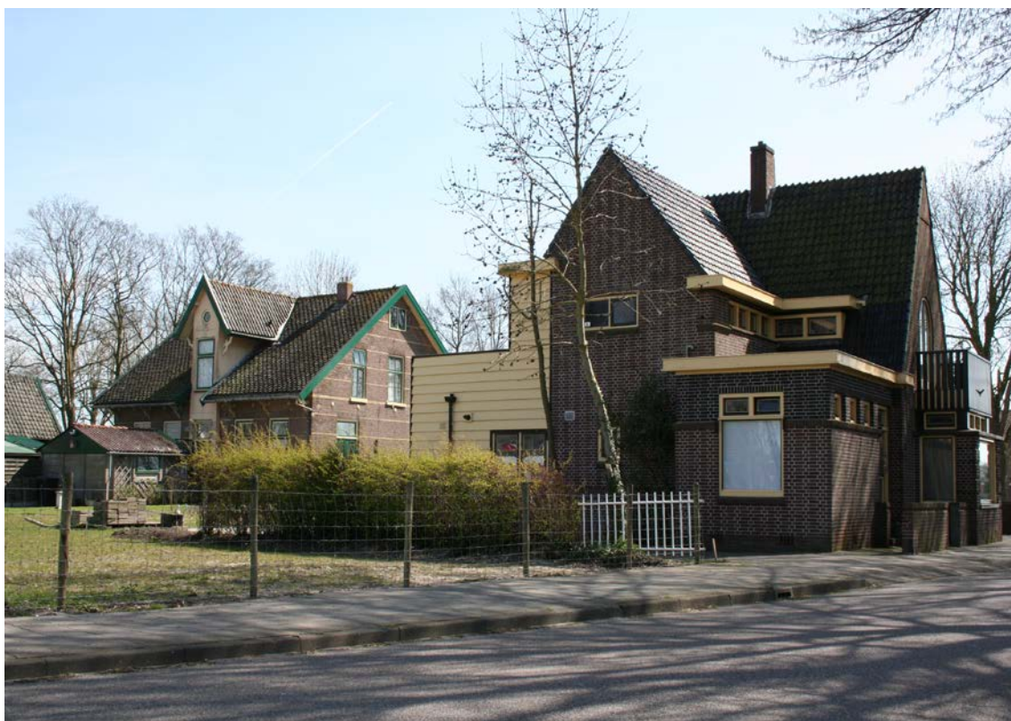
Figuur 5. Bestaande woning aan de Noorddijkerweg tussen de voormalige school
