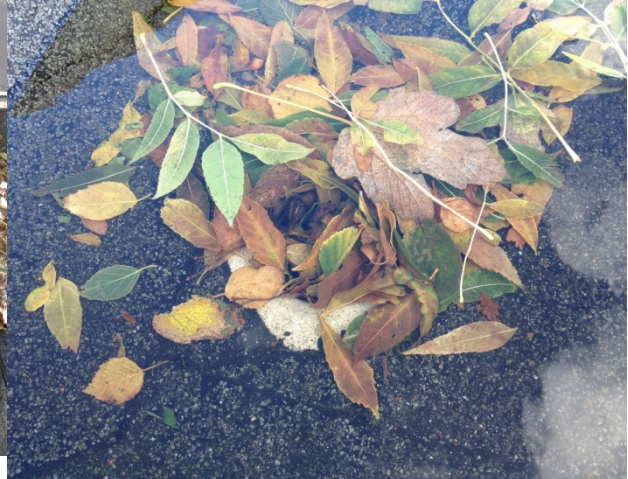
F28 Verstopte afvoer waarop ca. 150 mm water staat
