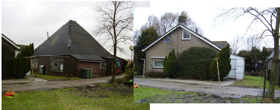
Figuur 10: de te slopen stolpschuur en de woning op nr. 9, locatie Wogmeer
