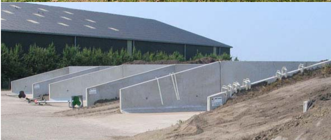
Ruimte voor separate opslag van grond, betonelementen en sleuvsilo's
