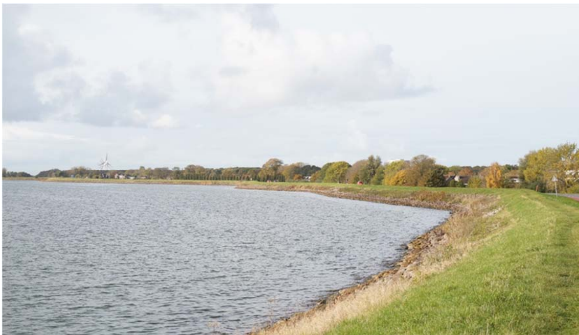
Afbeelding 11: Module 3: Markermeerdijk gezien vanaf de Galgenbocht naar het zuiden
