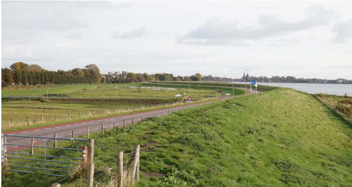
Afbeelding 12: Module 3: Markermeerdijk en het landje van Naber
