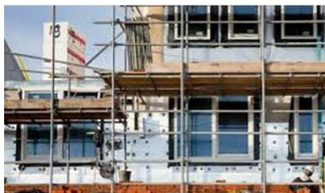
Figuur 10: een woning in aanbouw
