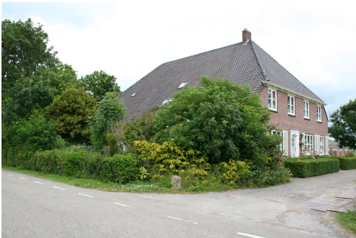
Foto bestaande oude boerderij
