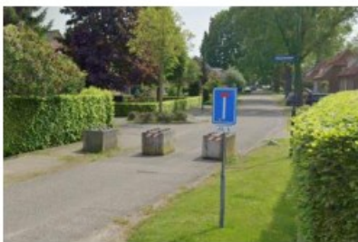
Figuur 15: Fysiek statische knip met betonblokken
