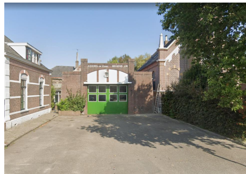
Figuur 7: Voorkant bebouwing Scharwoude 12
