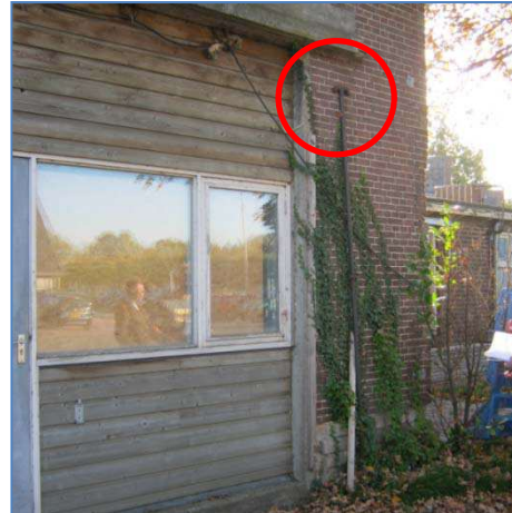
Figuur 3: Voorzijde Scharwoude 13 en ontluchtingspunt ondergrondse tank
