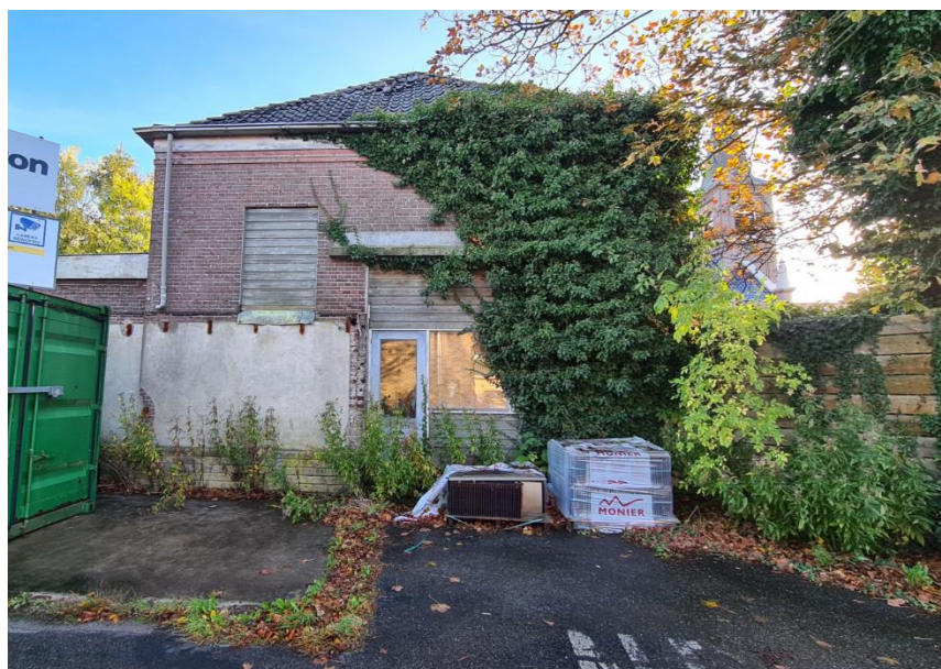
Figuur 6: Zijkant bebouwing Scharwoude 12
