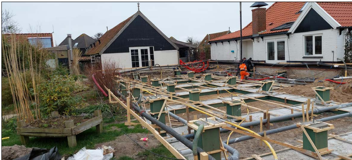
Eind februari 2023 was de bouwkuip van de nieuwbouw op Oost 76a uitgegraven.
